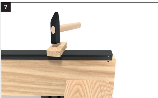
7 Platzieren Sie die neue Laufschiene nun auf der Holzschiene und schlagen Sie diese mit Hilfe eines Hammers ein. Benutzen Sie eine Unterlage (z. B. Holz oder Pappe), damit die Laufschiene nicht beschädigt wird.
